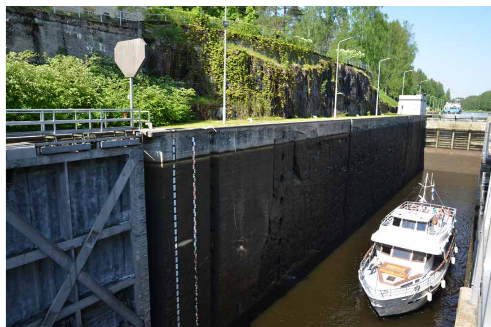
Yläkuvassa Mälkiän vanha sulkuryhmä vuodelta 1856. Alakuvassa Mälkiän nykyinen salku (putouskorkeus 12,4 m). Taustalla näkyvässä louhittua graniittiseinämää.
